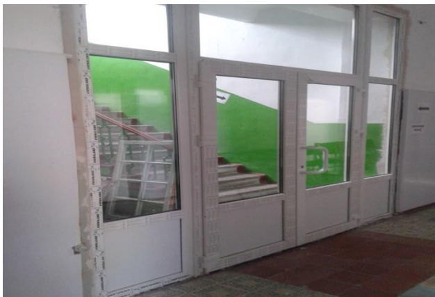
На фото головний корпус Шевченківської центральної районної лікарні
